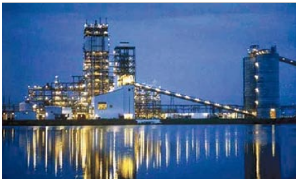
250-megawatowa elektrownia IGCC im. J.K. Polka w okolicach Lakeland na Florydzie
